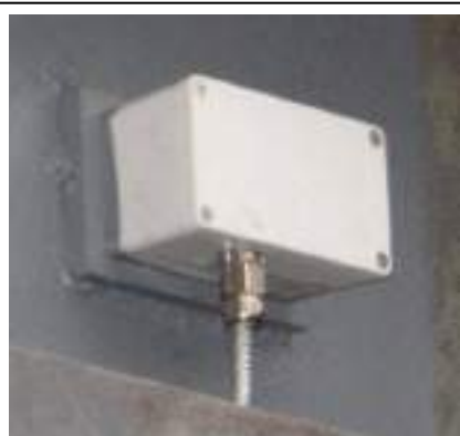
Рис. 2.5.1.2. Акустический датчик частичных разрядов марки «AC-Sensor» в монтажном корпусе.
